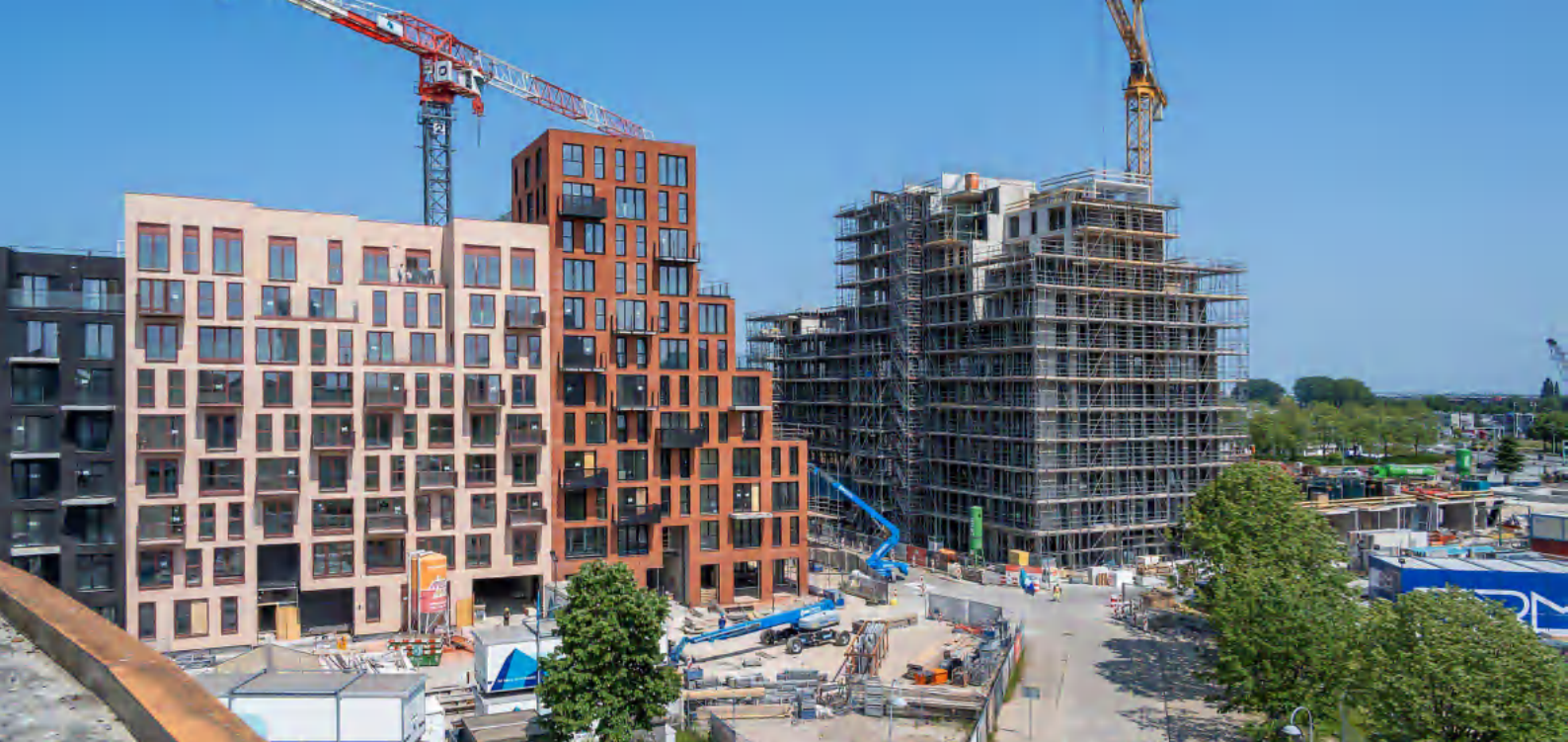
Hydepark in Hoofddorp in aanbouw
